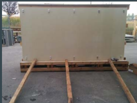
Плита Laminam 12+ с уже смонтированными анкерами
